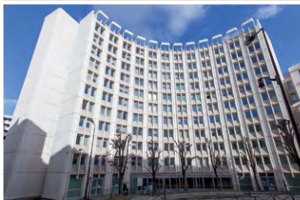
Rue du Château des Rentiers Paris (75013)
